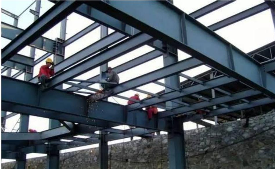
钢结构指主要由钢制材料组成的结构，是主要的建筑结构类型之一。结构主要由型钢和钢板等制成的钢梁、钢柱、钢桁架等构件组成，各构件或部件之间通常采用焊缝、螺栓或铆钉连接。因其自重较轻，且施工简便，广泛应用于大型厂房、场馆、超高层等领域。
